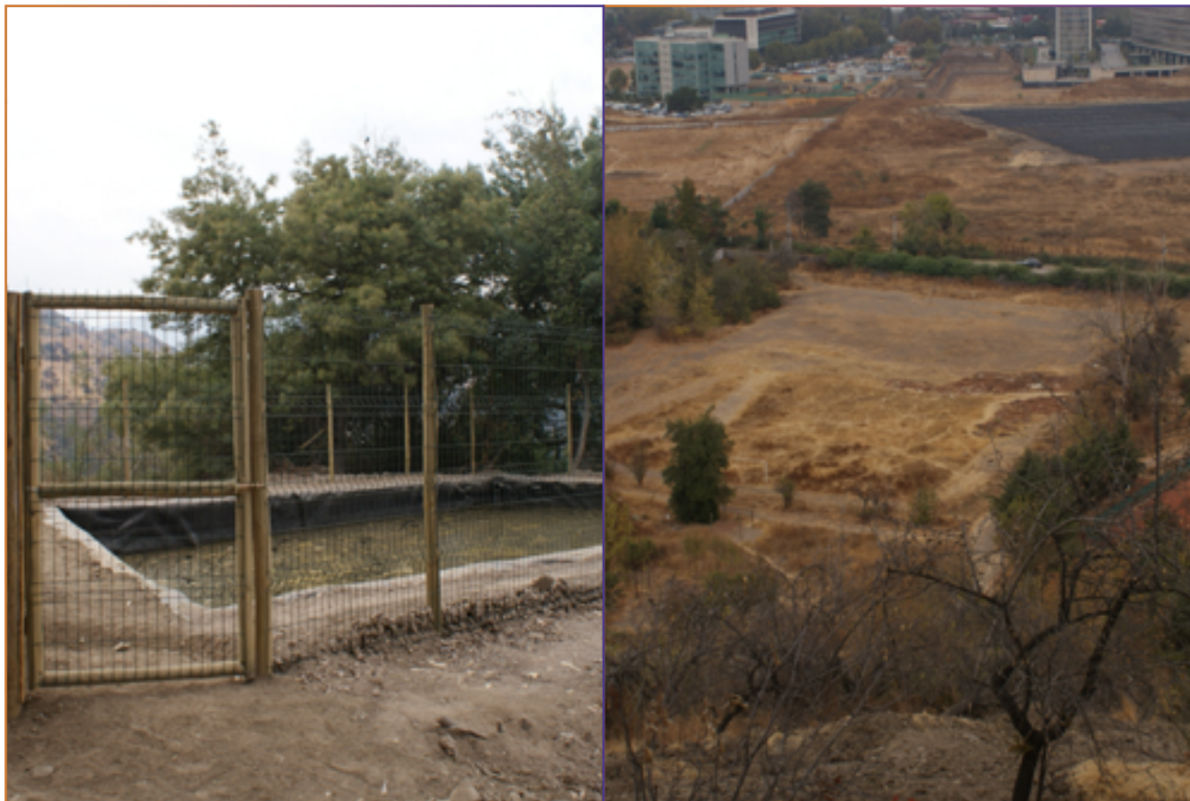
El tranque fue impermeabilizado y cercado completamente.
